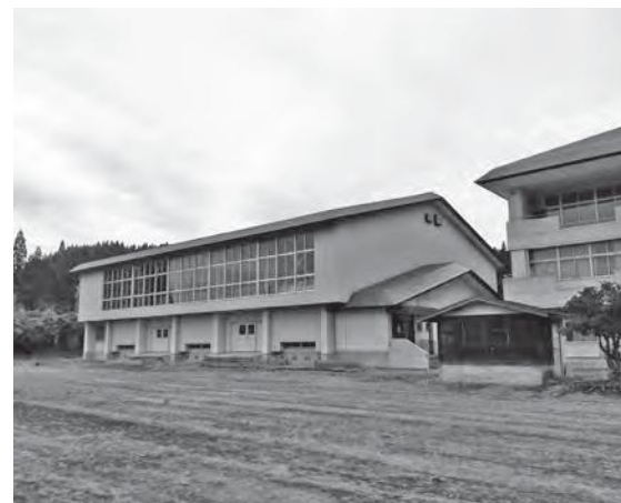
旧笹間第二小学校体育館
